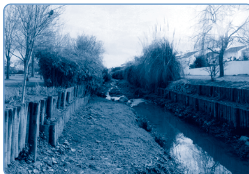
Figura 33 Aplicação de paliçadas com vegetação
